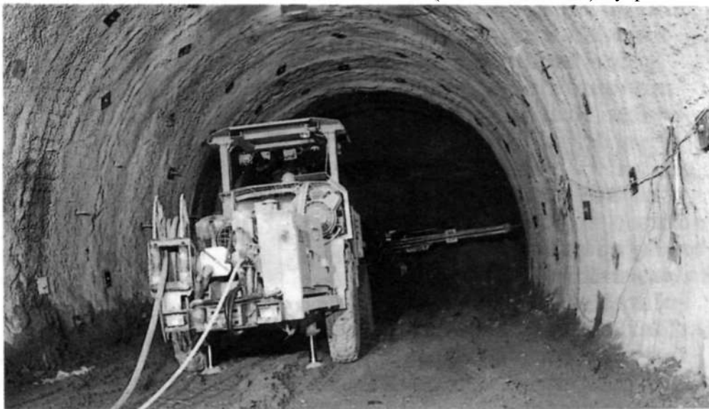
Metro Tünellerinde Jumbo ile Bulon delikleri delinirken
