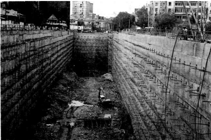
Gayrettepe İstasyonu Tünelleri İnşaatı
