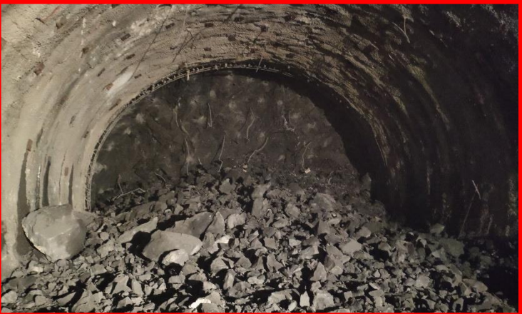
UYGUN İLERLEME VE DÜZGÜN TÜNEL CİDARI
