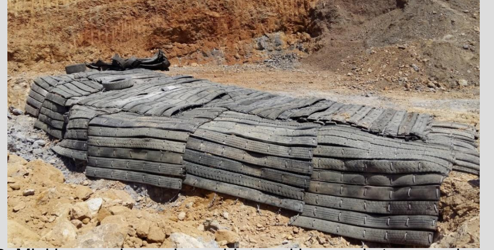
Şekil 6. Mini basamak uygulanan bir temel kazısında taş savrulmasını önlemek için kullanılan örtü.
