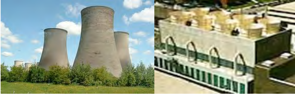
Şekil 5. Soğutma kule tipleri
