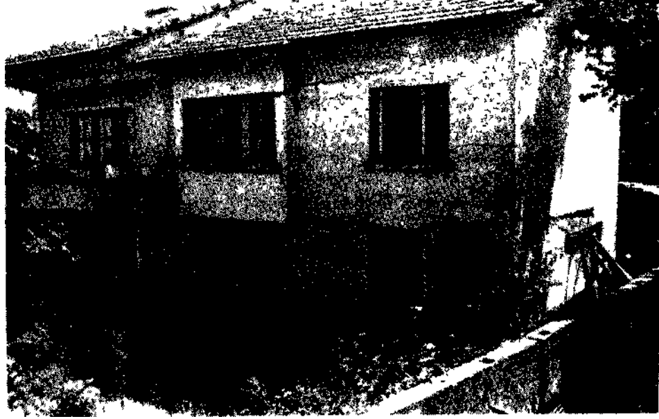
Resim 4: Zonguldak Bahçelievler semtinde tasman hasarı görülen bir ev
