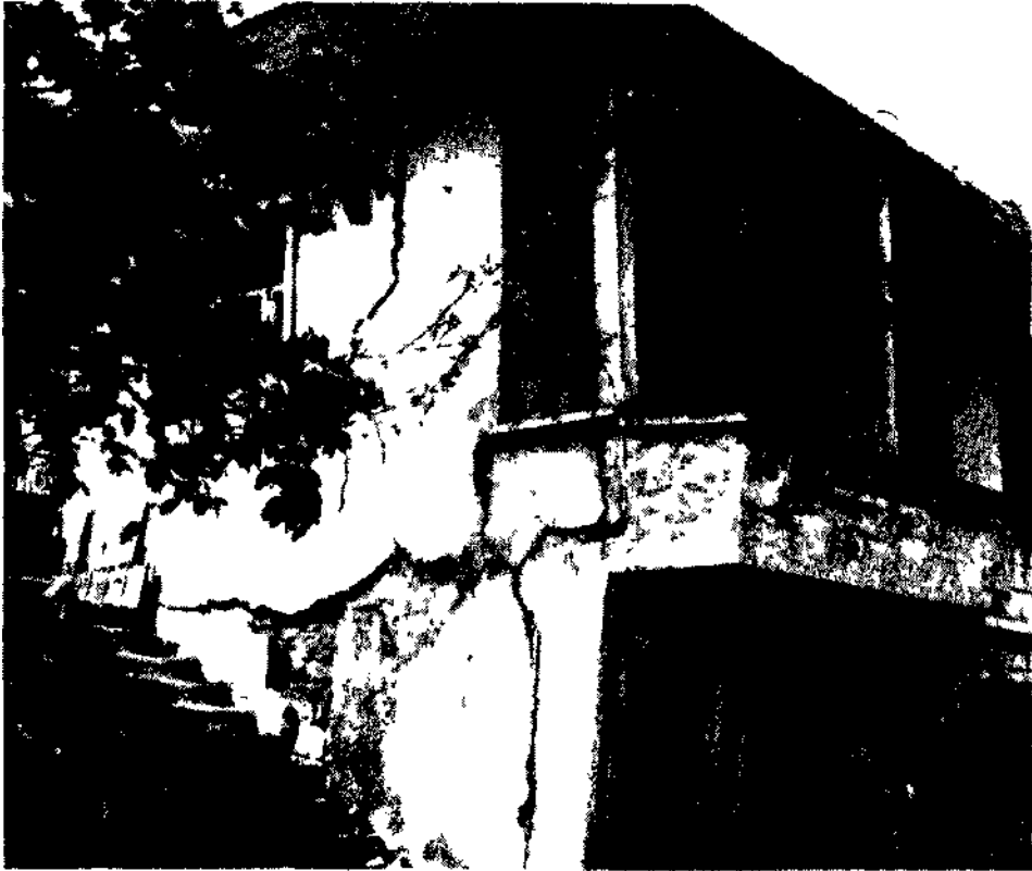
Resim 1 ve 2 Şekil 3'te görülen Kozlu koprusu kuzeyi çay imalatından oluşan tasman hasarları (kompresyon hasarları)
