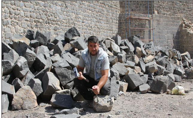
Resim 7. Diyarbakır surlarında bazalt taşı kullanımı ve onarım çalışmaları (URL 2)
