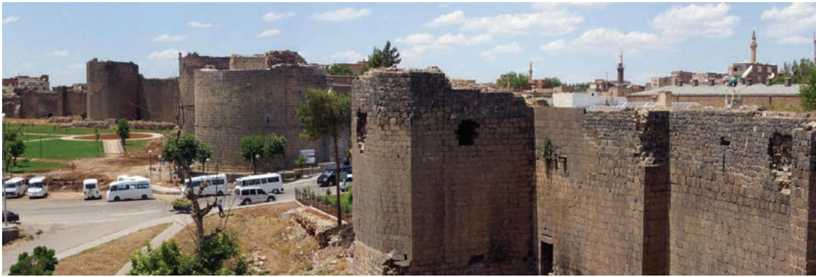
Resim 9. Surlarda bazalt örgü sistemi ve kaplama taşlarında tahribatlar (URL 3)
