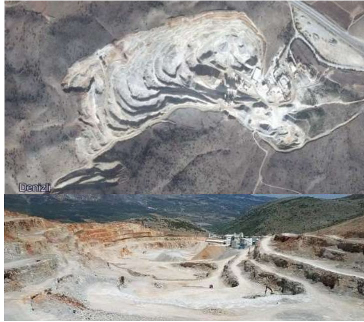
Şekil 3.Çalışması yapılan agrega işletmesinden görünüm
