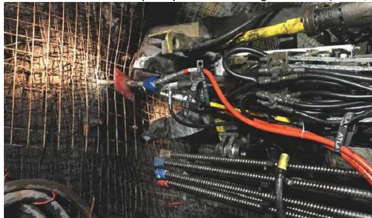
Şekil 9. Jumbo turuncu hortumlar ile montajlanmış enjeksiyon pompası
