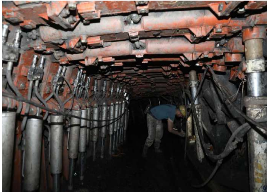
Şekil 2.Esnek Yarı Mekanize Tahkimatlar
