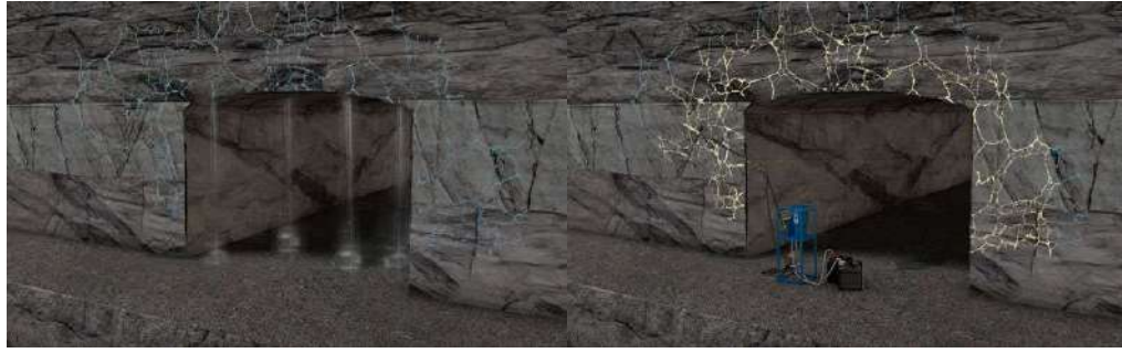
Şekil 7. Enjeksiyönöncesivesonrasıgaleridurumları (Weber Katalog 2019)
