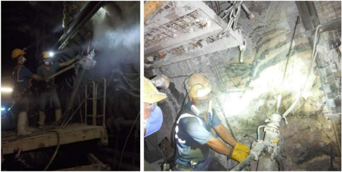
Şekil 9. Halat saplama uygulaması (Moore, vd., 2017)
