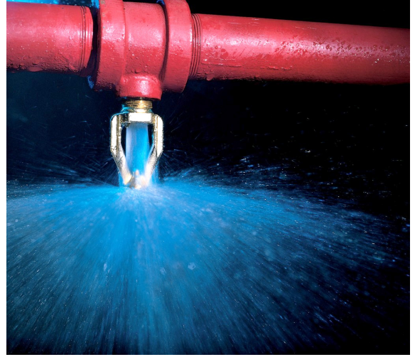
Şekil 9. Fiskiye sistemi ile söndürme/bastırma (Anon(b), 2016)
