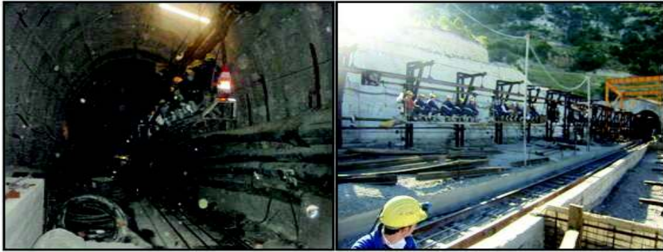
Şekil 2. Hazırlık galerilerine insan ve malzeme nakliyatı.
