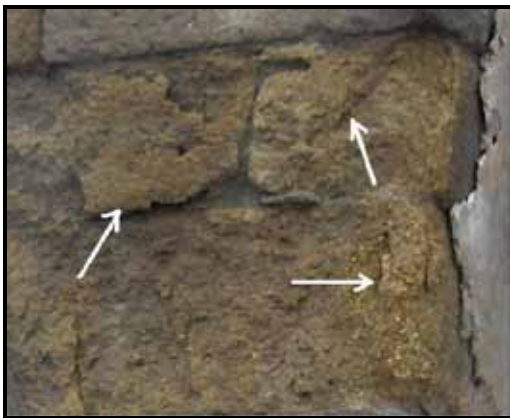
Şekil 7. Abdi Kadı çeşmesinde ayrışan kayaçlarda pul pul dökülmenin fotoğrafı.
