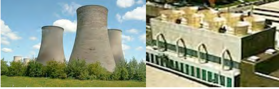
Şekil 5. Soğutma kule tipleri
