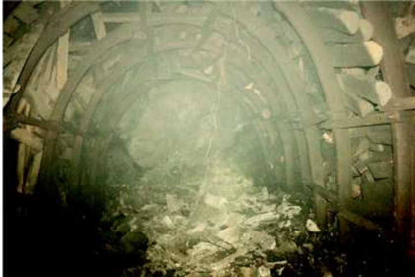
Şekil 3. Patlatma sonrası galeri arınının görünümü (Şekil 2a şablonu için).
