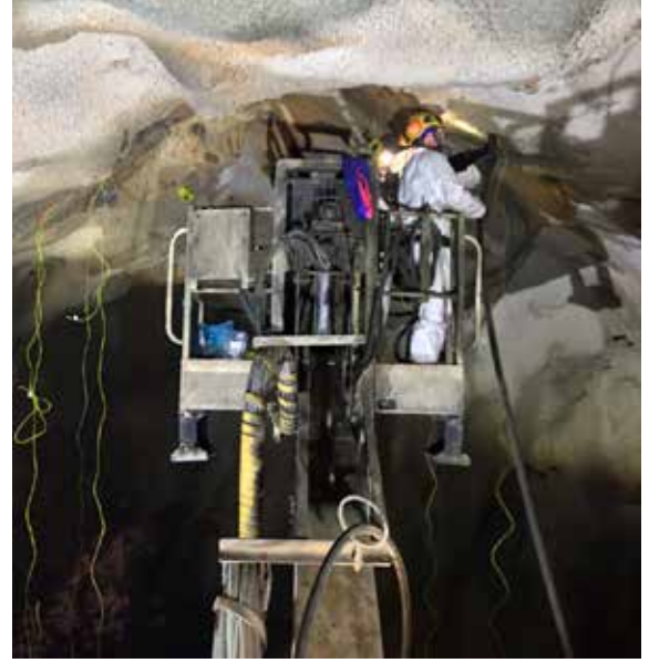
Şekil-8. Normet Charmec katarası (Slot) dolumu
